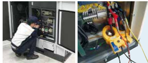
電力測定作業
