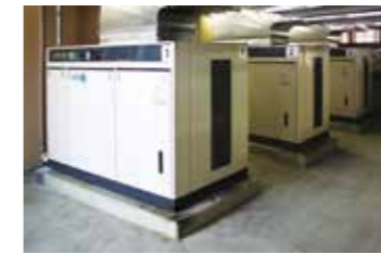
導入例:製造工場にて SAS55SD 3台を台数制御システムにて運用。
